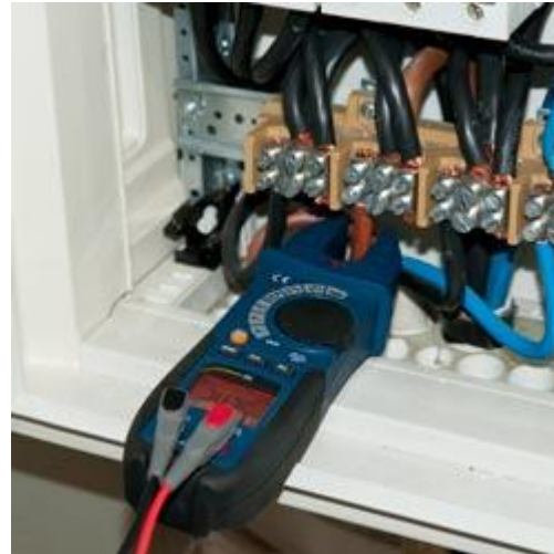
Stroommeting met de stroomtang
