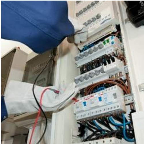
Spanningsmeting met de vorkstroomtang
