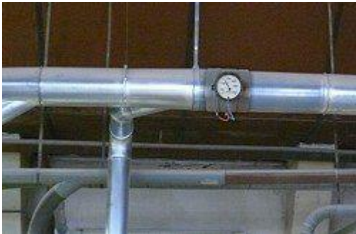
Hier ziet u de Venturi PCE-VR, geïnstalleerd in een leiding.
