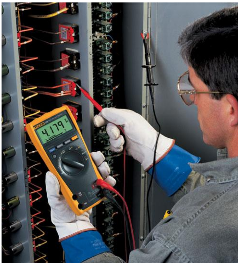
De TRMS digitale multimeter FLUKE 177 in gebruik bij onderhoud van een schakelinstallatie.
