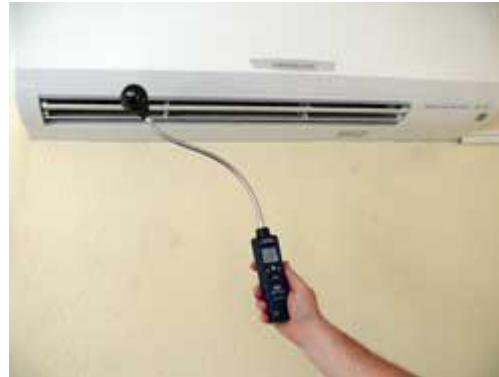
De thermo-anemometer met vleugelwiel terwijl hij een meting verricht in een airconditioning apparaat.
