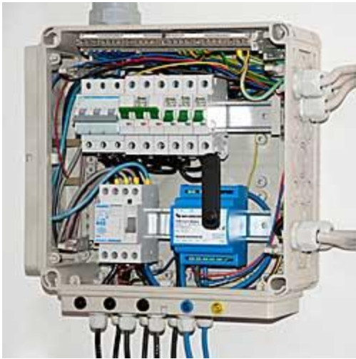
Hier kunt u het SMS-alarmsysteem zien dat in een open kast is geïnstalleerd.
