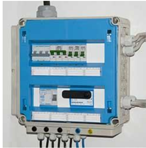
Hier kunt u het SMS-alarmsysteem zien dat in een gesloten kast is geïnstalleerd.
