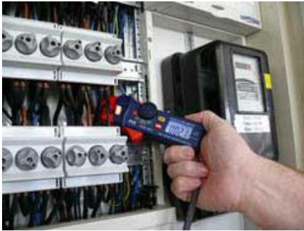
Spanningstest van een elektrisch paneel met de multimeter ampèretang
