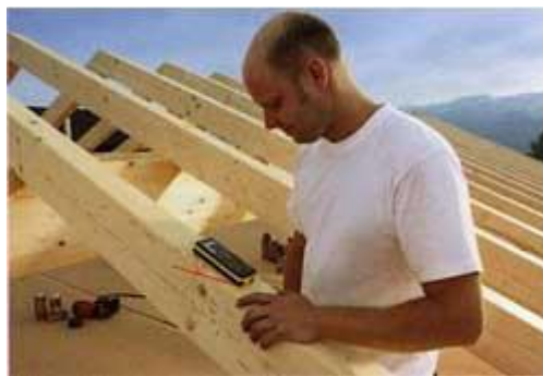
Laser-afstandsmeter Leica Disto D5 met geïntegreerde inclinatiesensor om de hoek te bepalen.
