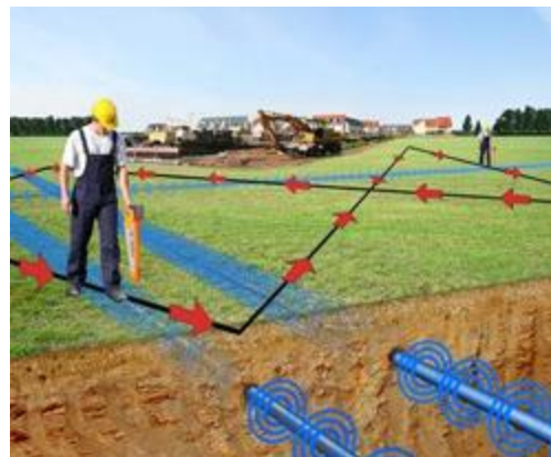
De Kabelzoeker Easyloc in het sonderen van een perceel.
