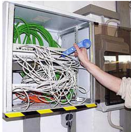
Toongenerator die dient om een signaal in de telefoonlijn of het LAN netwerk in te voeren.
