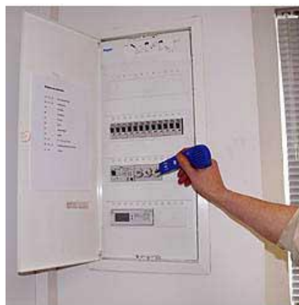
Tester tijdens het zoeken naar een telefoonlijn van de toongenerator.
