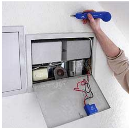
Tracering van een telefoonsnoer of LAN netwerkkabel
