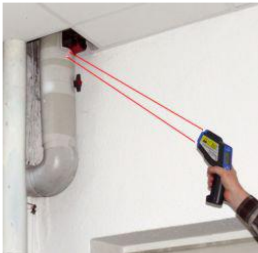
Hier ziet u de infrarood thermometer bij het maken van een puntmeting in een verwarmingspomp.
