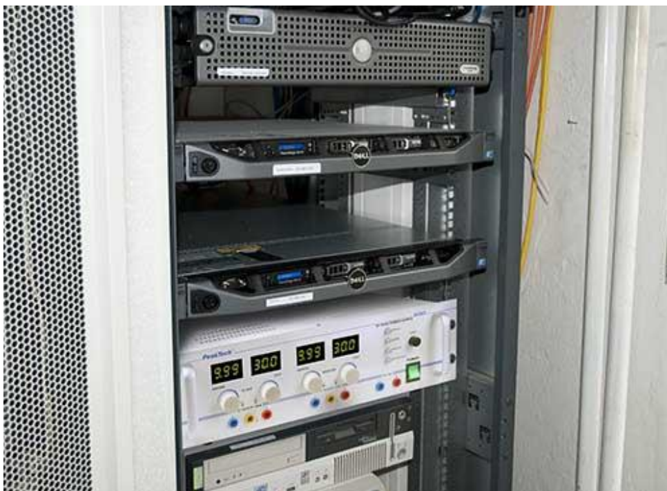
Het 19-inch-voeding in een rack gebouwd
